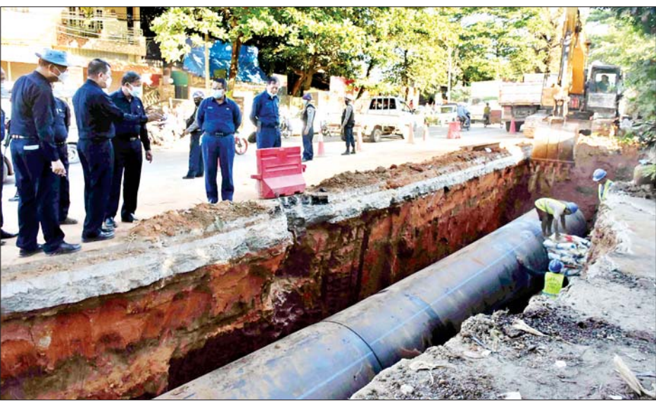
လုပ်ငန်းဆောင်ရွက်နေမှု၊ ရေတွန်း ပြီးစီးမှု၊ ပြည်လမ်းတစ်လျှောက် ခြင်းလုပ်ငန်းနှင့် ဖူးကြီး-လှော်ကား စက်ရုံဓာတ်အားခွဲရုံတည်ဆောက် 1600 mm HDPE ပိုက်ဆက်သွယ် ၆၀ လက်မ ကွန်ကရစ်ပိုက်သို့
