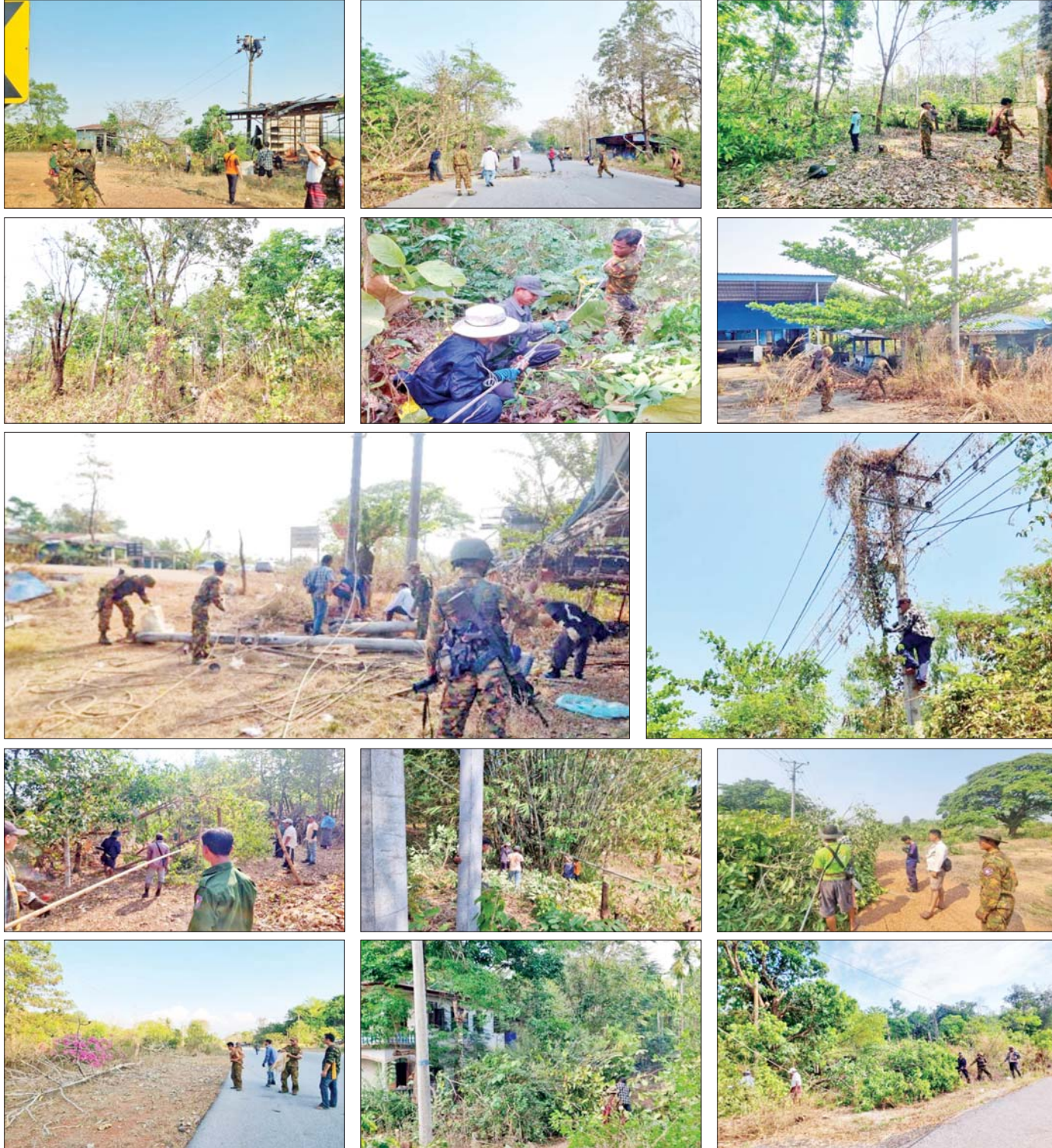
ကရင်ပြည်နယ်ရှိ ၁၁ ကေစီ ကျိုဒီး-ကော့ကရိတ် ဓာတ်အားလိုင်းတစ်လျှောက် ဓာတ်အားလိုင်းများ ပြန်လည်ပြုပြင်ဆောင်ရွက်ခဲ့မှုများကို တွေ့ရစဉ်။
