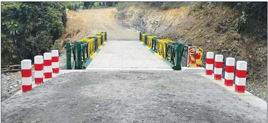
ဒါးဆိပ် - နောင်လုံဝမ်းစစ် - ဟိုက်ကွေ့လမ်းပေါ်ရှိ သံကူကွန်ကရစ် ချောင်းကူးတံတားတစ်စင်း တည်ဆောက်ပြီးစီးမှုကို တွေ့ရစဉ်။
