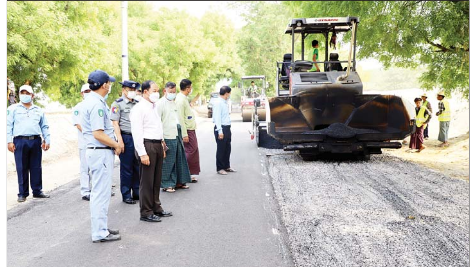
တိုင်းဒေသကြီး စည်ပင်သာယာရေးအဖွဲ့ ညွှန်ကြား ရေးမှူးက ရာပြည့်ဘုရားကျွန်းပတ်လည် ပေ ၂၃၀၀ နှင့် ပြည်ထောင်စုကျွန်းပတ်လည် ပေ ၂၂၅၀ မြေထိန်း ကျောက်ထုတ်လောင်းခြင်းလုပ်ငန်းများနှင့် ရာပြည့် ဘုရားရင်ပြင်တော် နေပူခံကျောက်ပြားများခင်းကျင်း ခြင်းလုပ်ငန်း ဆောင်ရွက်နေမှုများနှင့်ပတ်သက်၍ ရှင်းလင်းတင်ပြသည်။ ယင်းနောက် တိုင်းဒေသကြီးဝန်ကြီးချုပ်က
