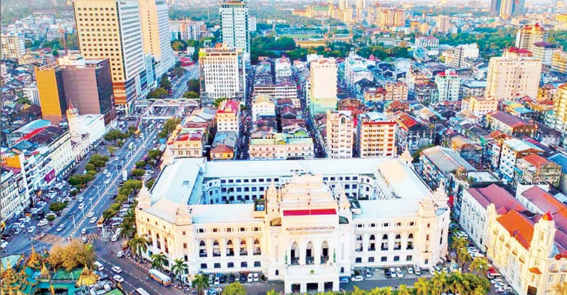
ကွန်ကရစ်အခြေခံအဆောက်အအုံများဖြင့် ဖွံ့ဖြိုးတိုးတက်နေသော ရန်ကုန်မြို့ကို တွေ့ရစဉ်။
