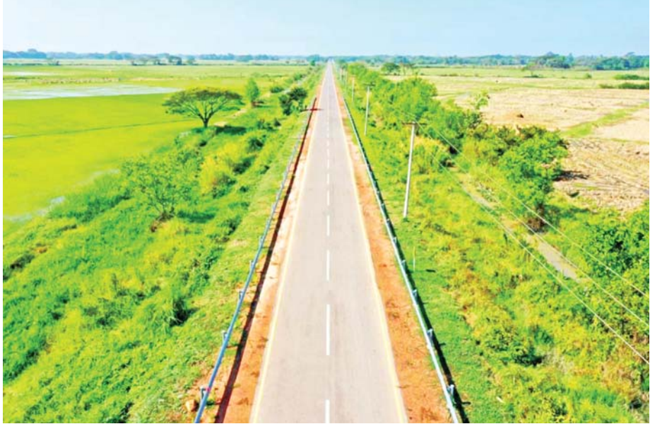
လမ်းကွန်ရက်အမှတ်(၁၀) ဘိုကလေး-မော်လမြိုင်ကျွန်း-ကျိုမင်းလမ်းကို တွေ့ရစဉ်။
